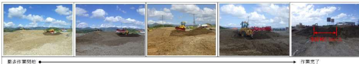
第5図 土砂撤去状況写真
