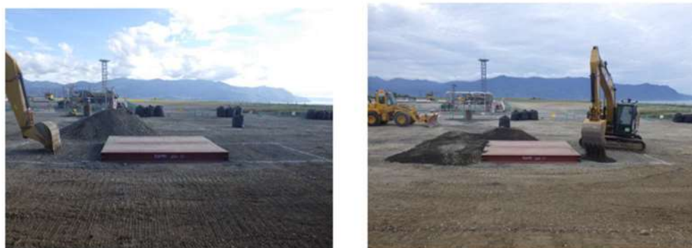
第10図 段差復旧状況
