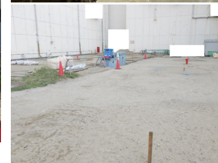
地盤改良後(R4年7月撮影)
