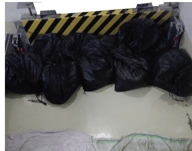
堰部に土嚢設置
