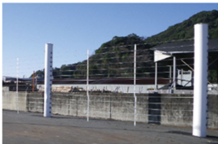
津波漂流物防護柵の設置イメージ
