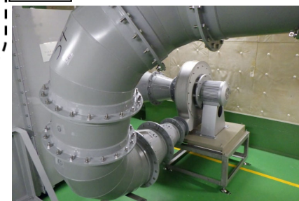
可搬型換気設備の設置時の様子
