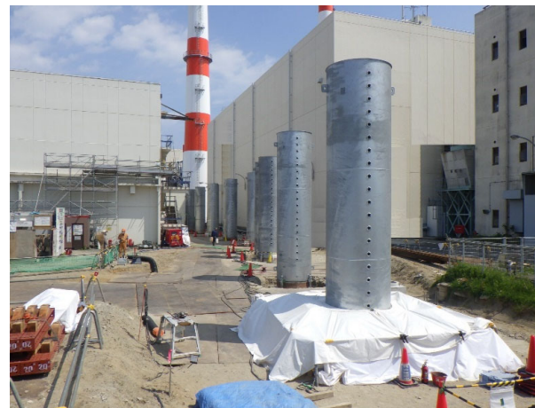
支柱建込(R5年5月撮影)
