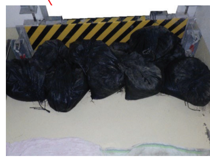
土嚢の設置状況
