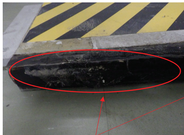
接地面のゴム (経年劣化による硬化を確認)
