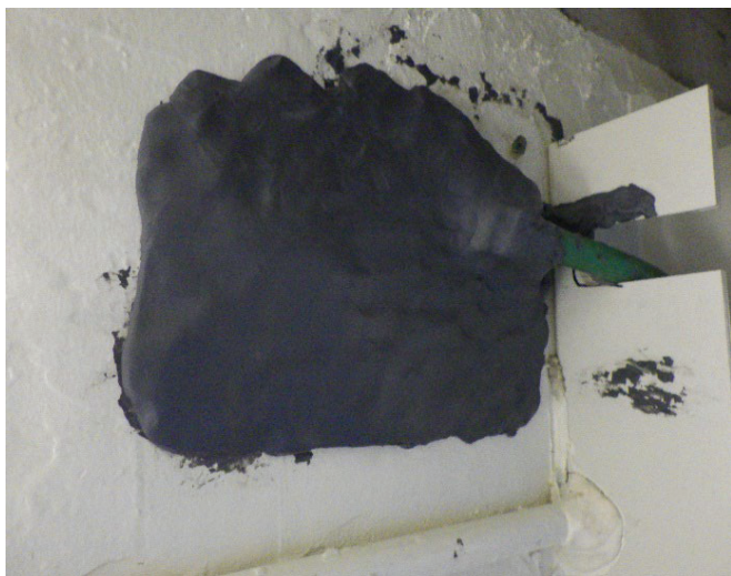
追加の止水材取付け
