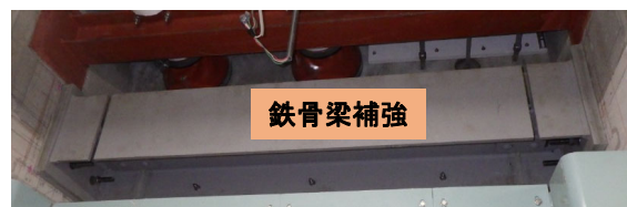
鉄骨梁補強箇所(天井パネル内)
