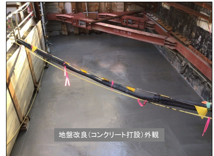
地盤改良工事の状況(令和3年12月)
