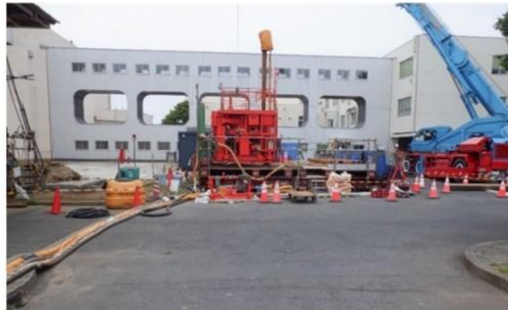
地盤改良の試験施工
