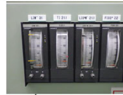
④温度指示計(制御盤)
