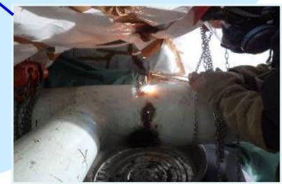
ECCS系配管の切断作業
