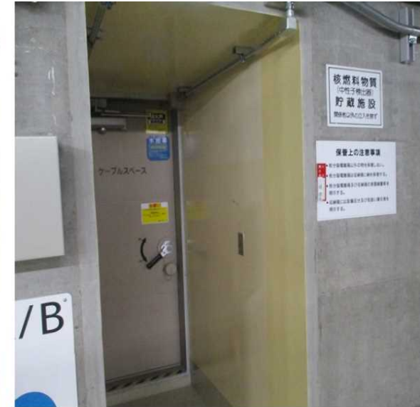
<現在の扉の様子>
