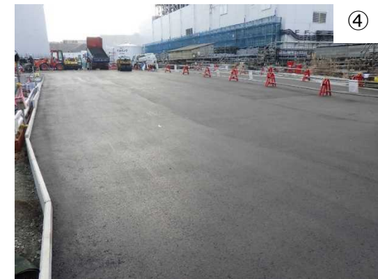
3号機側から4号機側を臨む。 (2023.1月末完了)
