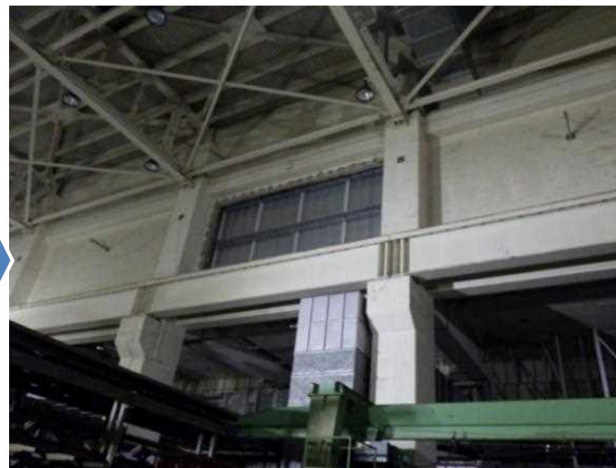
写真②：BOP損壊部分（塞ぎ後、屋内側）
