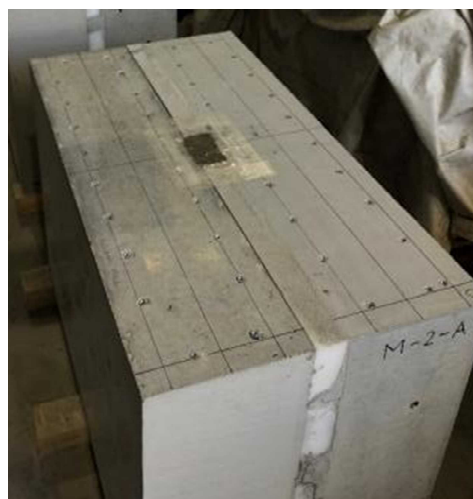
手順5：止水材（モルタル）注入完了
