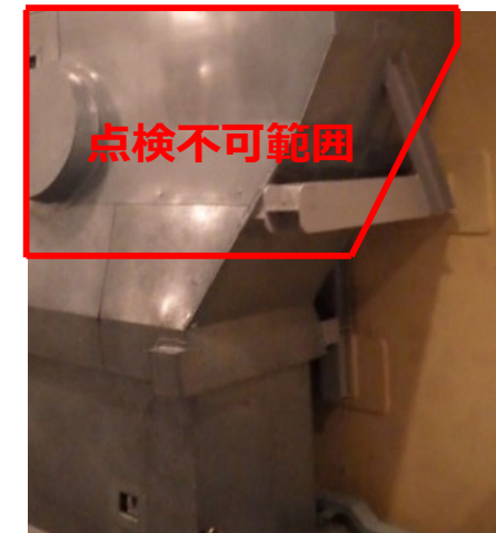
換気空調用ダクト裏 (高浜4号炉の写真)
