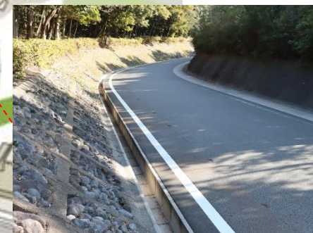
発電所構内道路の側溝
