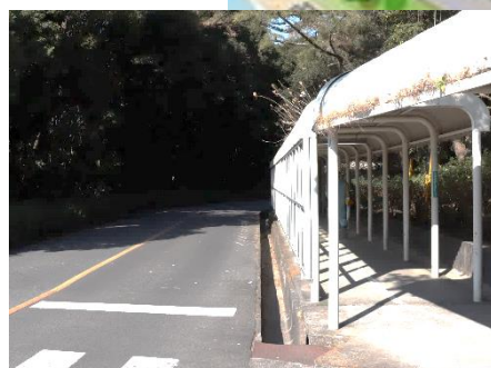
発電所構内道路の側溝
