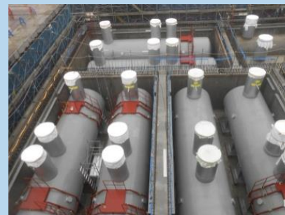
地下燃料タンク外観 （埋戻し前の工事中写真）
