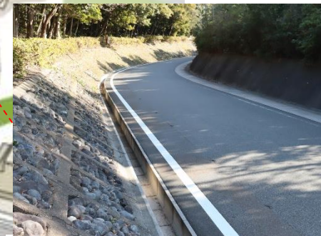
発電所構内道路の側溝
