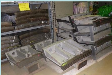
○浜岡 2 号機制御棒駆動水圧制御ユニット解体（原子炉建屋内）
