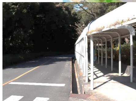
発電所構内道路の側溝
