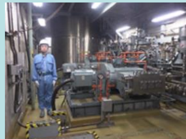
○浜岡 1 号機ほう酸注入系（原子炉建屋内）
