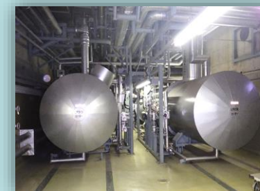
○浜岡 1 号機低圧給水加熱器解体（タービン建屋内）
