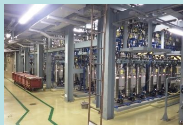
○浜岡 1 号機ほう酸注入系（原子炉建屋内）
