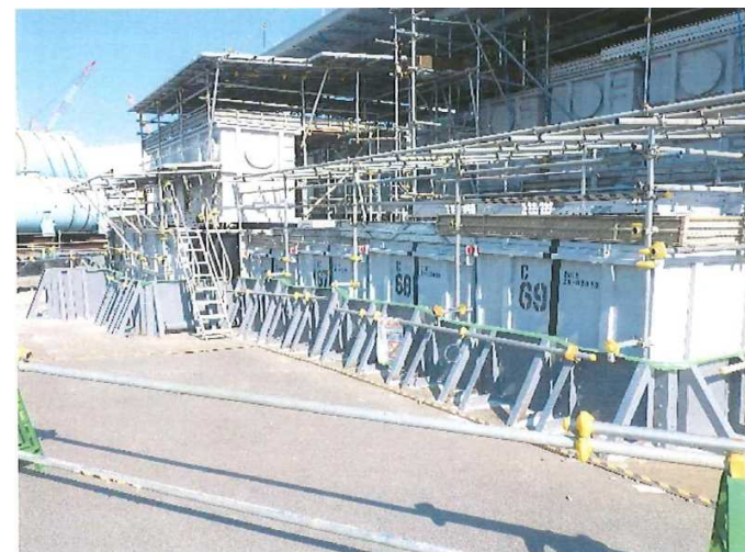
※1 屋根、足場、止水堰
