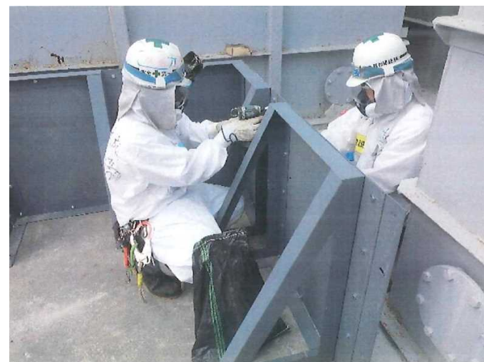
※4 止水堰の設置状態
