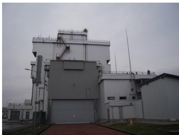
使用済燃料中間乾式貯蔵施設（ISF-2）正面
