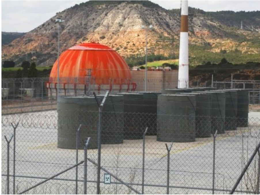
図 2.1-32 ホセカブレラ発電所の乾式貯蔵施設（コンクリートキャスク） [ESP3]
