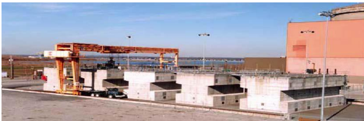
図 2.1-8 ジャンティリイ 2 号原子力発電所の MACSTOR-200 システム[CAN10]
