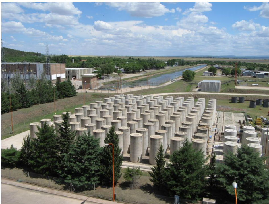
図 2.1-3 エンバルセ原子力発電所の乾式貯蔵施設[ARZ3]
