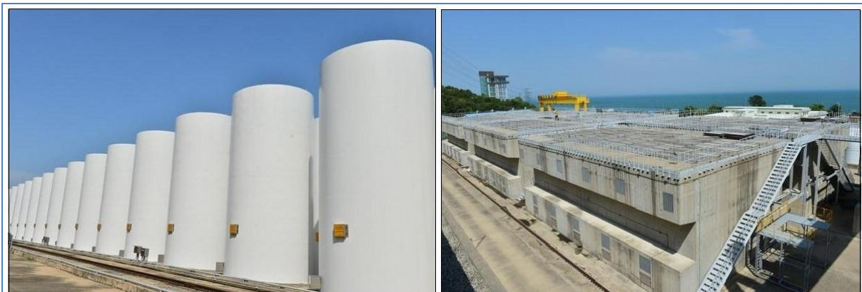
(コンクリートサイロ方式)
