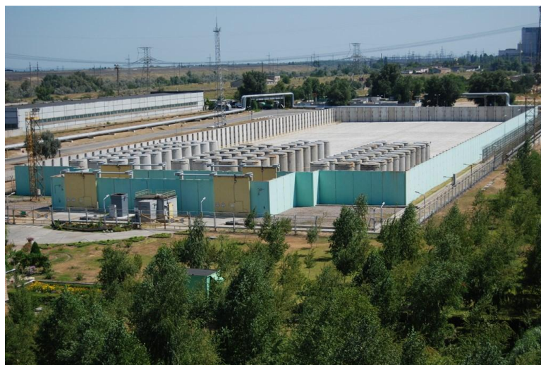
図 2.1-40 ザポロジエ発電所の乾式貯蔵施設[UKR1]
