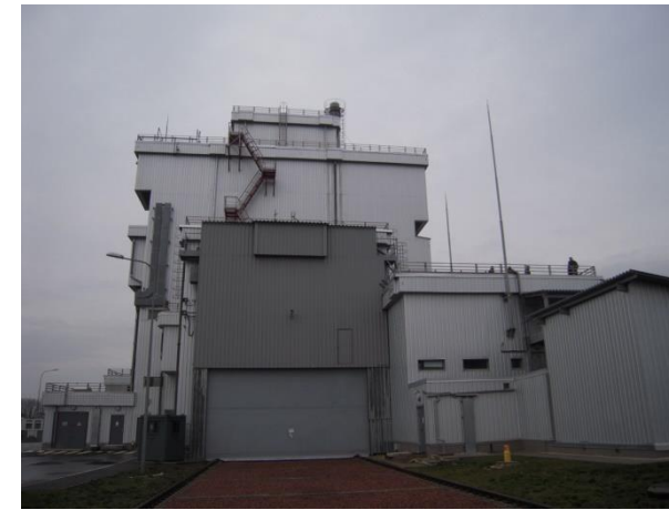
使用済燃料中間乾式貯蔵施設(ISF-2)
