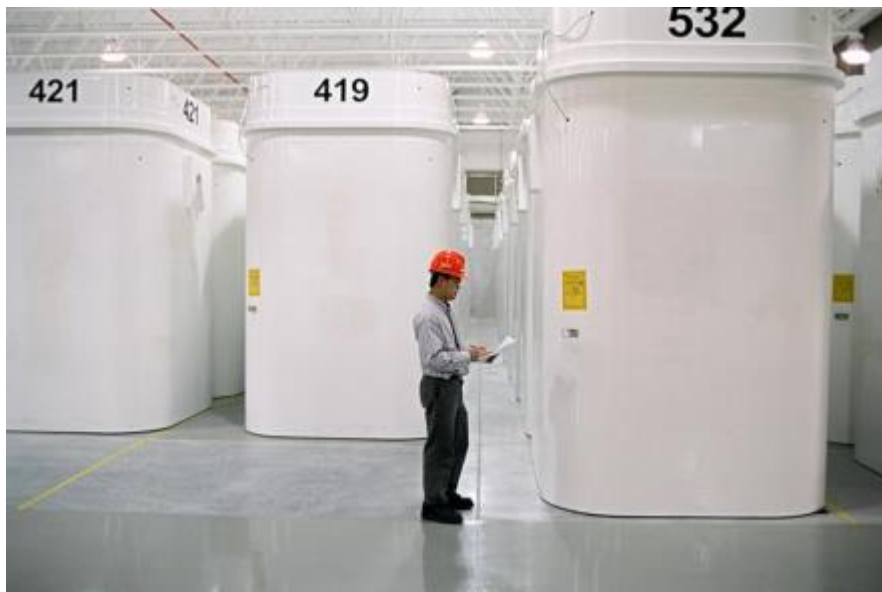
図 2.1-10 OPG の乾式貯蔵施設における DSC の貯蔵状態 [CAN10]
