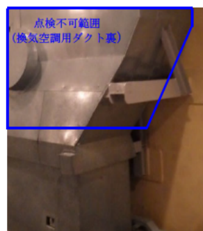
図5. 1 接近可能だが要領書で定めたデータ採取方法の要求条件が確保できない範囲の例
