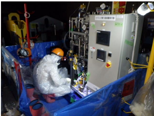
フィルタ通水試験装置写真
