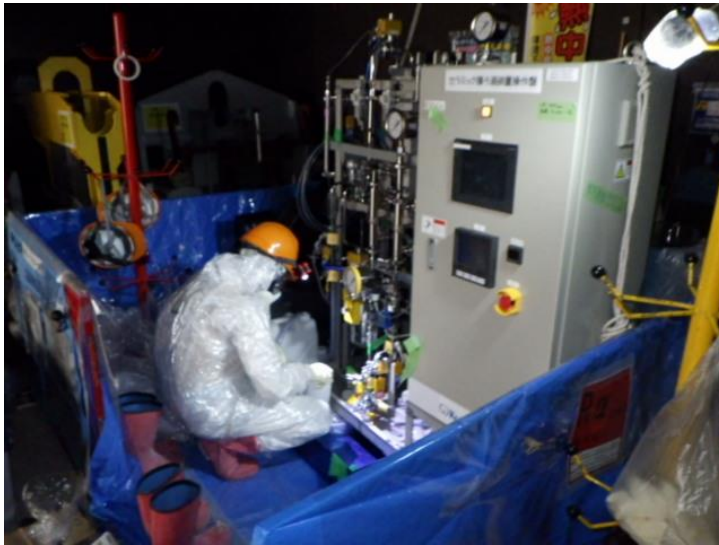
フィルタ通水試験装置写真
