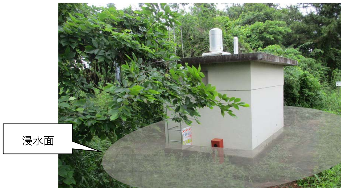
P-11 局舎周辺の浸水状況（担当者からの聞き取りに基づく再現）
