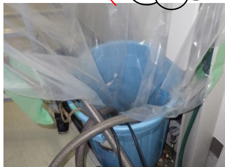
雨水の集水状況
