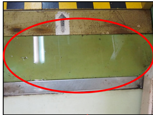
セル操作室（第2種管理区域） 出入口扉付近
