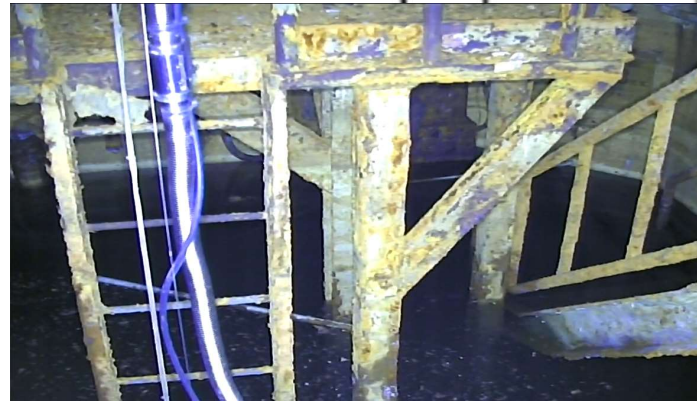
②西 (階段、空調設備)
