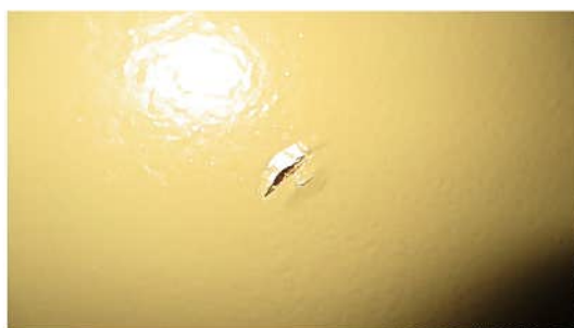
フロー②と判断した塗膜の劣化
