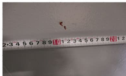
フロー②と判断した塗膜の劣化
