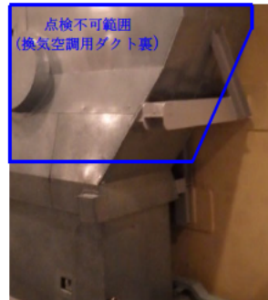
図3.9 点検不可範囲の例（換気空調用ダクト裏）
