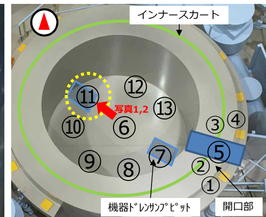
図2 1号機 原子炉格納容器内部調査状況(ペDESTAL内)
