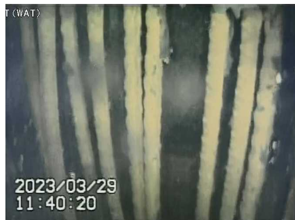
写真2.ペDESTAL内壁面部(下部)
