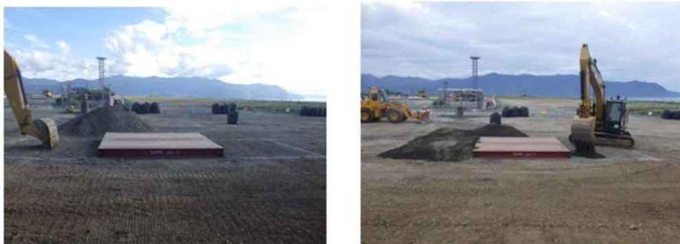
第10図 段差復旧状況
