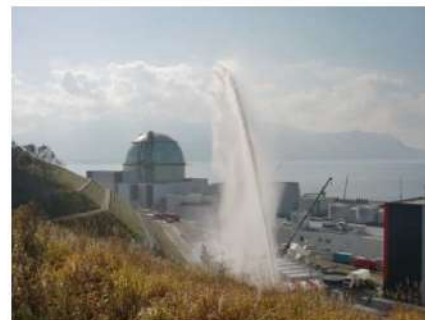
第10図 直状放射による放水状況
