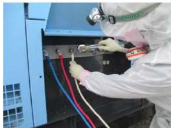
可搬型直流電源用発電機ケーブル接続 (屋外 T.P. 31m)
