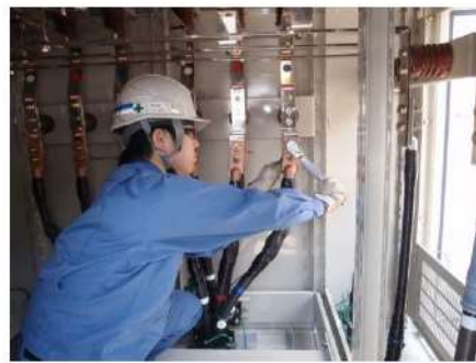
号炉間連絡ケーブル接続 （屋外T. P. 31m）
