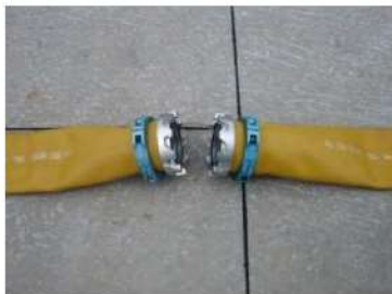
可搬型ホース (150A) 接続口
