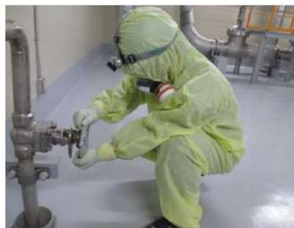
2次系補給水ポンプによる注水 (周辺補機棟 T.P. 14. 9m)
