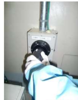
電源ケーブル接続
