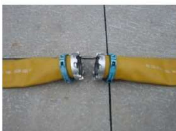
可搬型ホース(150A)接続口
