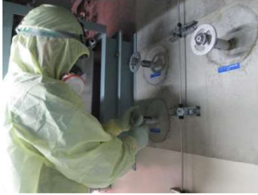
原子炉格納容器水素濃度監視系統構成 (原子炉建屋 T. P. 28. 0m)
