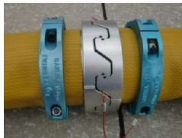
可搬型ホース（150A）接続後
