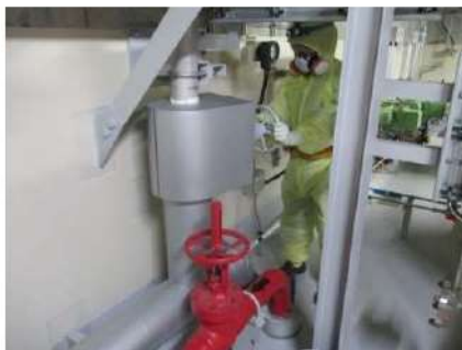
可搬型大型送水ポンプ車による原子炉格納容器下部への注水系統構成 （運転員（現場）B） （原子炉補助建屋 T.P. 10.3m）
