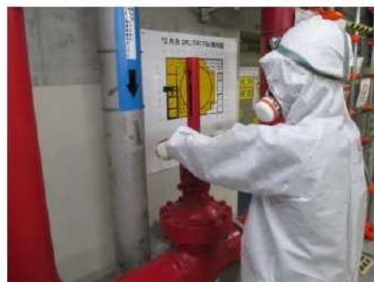
消火ポンプによる原子炉格納容器内へのスプレイ系統構成 （運転員（現場）C） （原子炉建屋 T.P. 17.8m）
