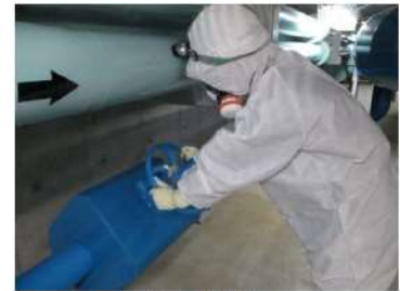
通水操作 (原子炉建屋 T.P. 2.3m)
