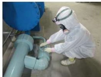
原子炉補機冷却海水系水抜き (ディーゼル発電機建屋 T. P. 6. 2m)
