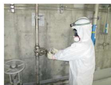
可搬型大型送水ポンプ車による 原子炉容器への注水 系統構成 (運転員 (現場) C) (原子炉建屋 T.P. 10.3m)
