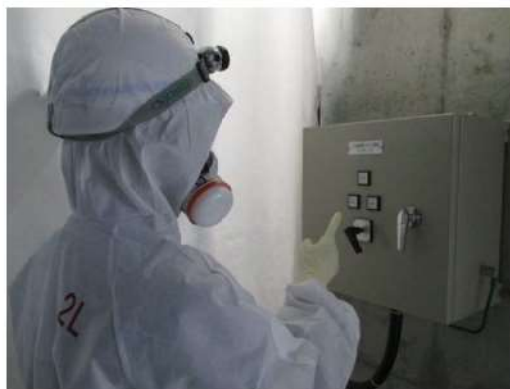
代替格納容器スプレイポンプ起動操作 (原子炉建屋 T.P. 10. 3m)
