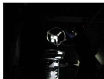
主蒸気逃がし弁開放操作(照明消灯時) (原子炉建屋 T.P. 33.1m)
