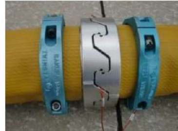
可搬型ホース (150A) 接続後
