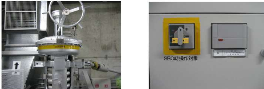
図 14 操作対象機器への反射テープ貼り付け例
