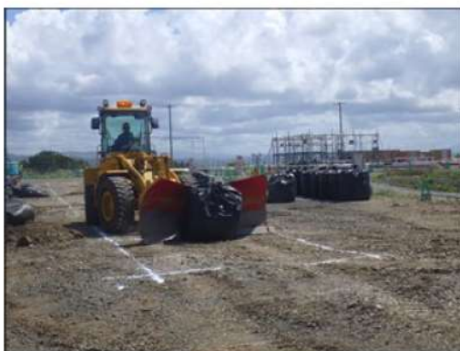
図4 がれき撤去訓練
