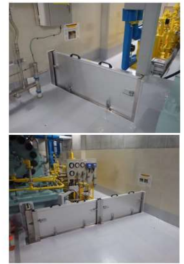
図5-4 止水板設置状況
