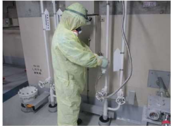
(制御用空気供給弁閉操作イメージ)
