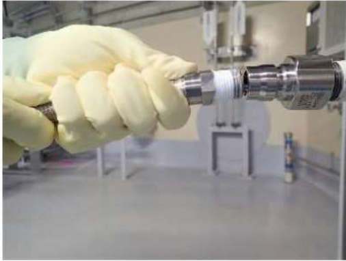
アニュラス排気ダンパのカプラ接続イメージ (原子炉建屋 T.P. 40. 3m)
