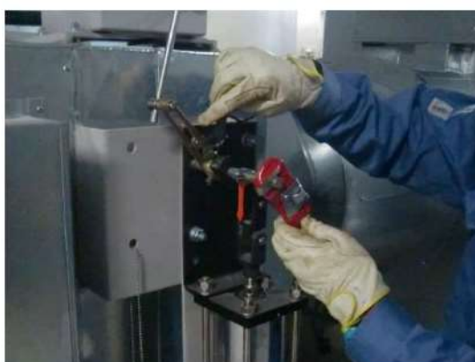
(空気作動ダンパ開又は閉作業イメージ)
