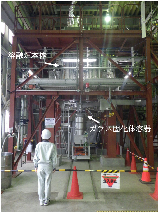
写真-1 3号熔融炉設置状況
