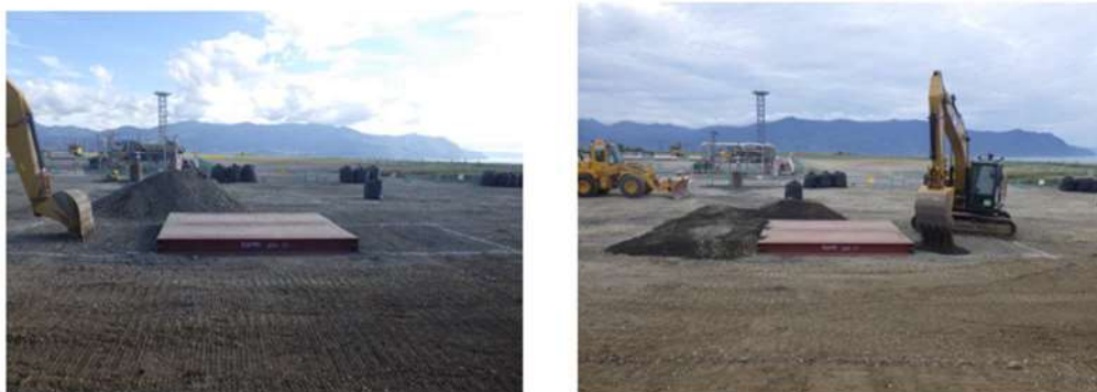
第10図 段差復旧状況
