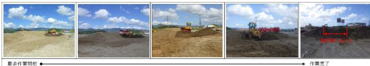
第5図 土砂撤去状況写真
