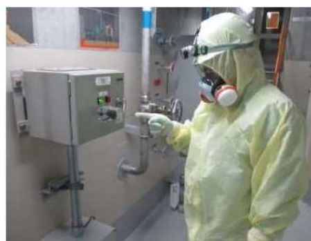
1次系補給水ポンプによる補給 (原子炉補助建屋 T. P. 17. 8m)
