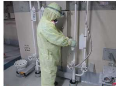
窒素供給操作 (系統側バルブ操作) (原子炉建屋 T.P. 40. 3m)
