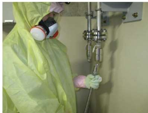
可搬型格納容器内水素濃度計測ユニット接続 (原子炉建屋 T. P. 24. 8m)
