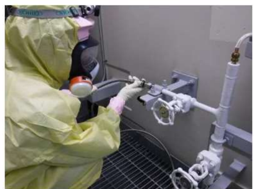
代替空気(窒素)供給用フレキシブル配管接続 (原子炉建屋 T. P. 21. 2m)
