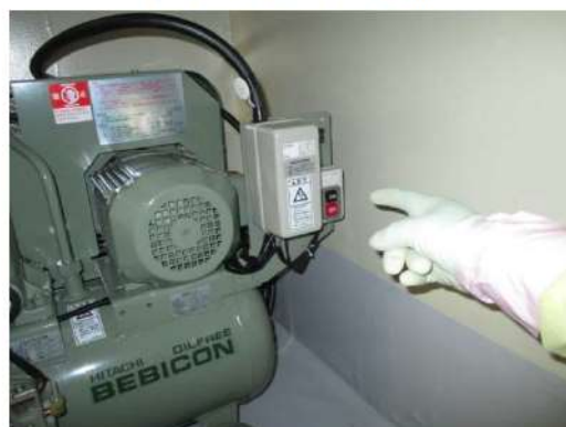
可搬型代替ガスサンプルリング圧縮装置起動 (原子炉建屋 T. P. 24. 8m)
