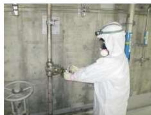
可搬型大型送水ポンプ車による原子炉格納容器内へのスプレイ系統構成 （運転員（現場）C） （原子炉建屋 T. P. 10. 3m）
