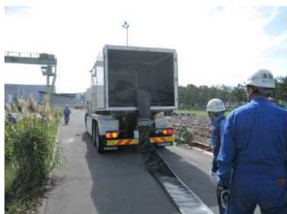
ホース延長・回収車（放水砲用）による ホース敷設 （屋外 T.P. 10.3m）
