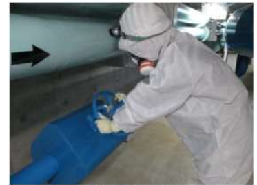
通水操作 (原子炉建屋 T.P. 2. 3m)
