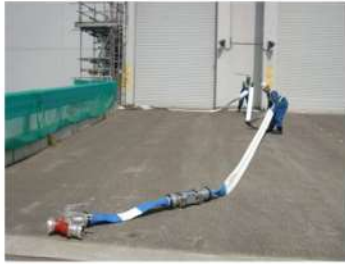
可搬型ホース敷設 (屋外 T. P. 33. 1m)
