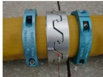
可搬型ホース（150A）接続後
