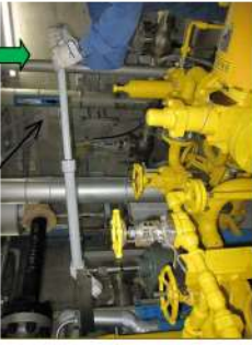
起動レバー (約 10 kg) 押し下げる
