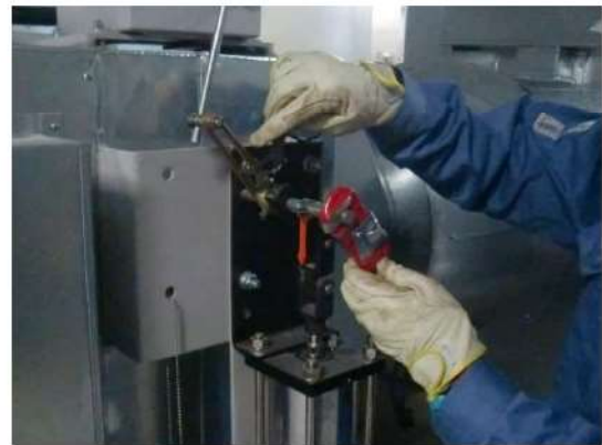
(空気作動ダンパ閉作業イメージ)
