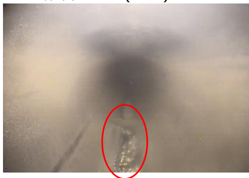
①RCW-Hx(A)(B)側の配管底部の堆積物
