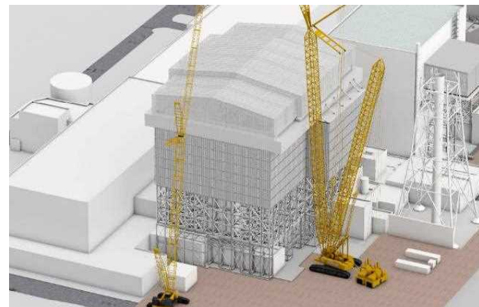
大型カバー設置工事完了
