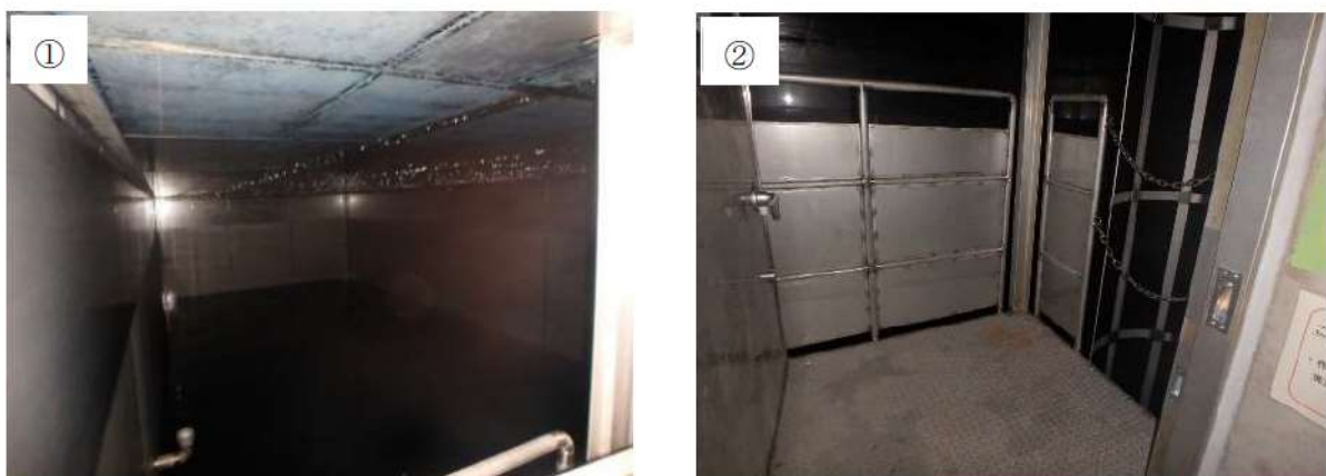
第 41-4-7 図：補助給水ピットの現場状況
