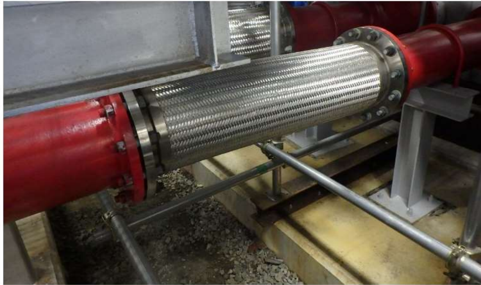
第 41-1-23 図 地盤変位対策の実施例
