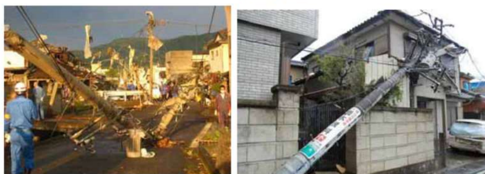
(電柱の折損, 傾斜)
