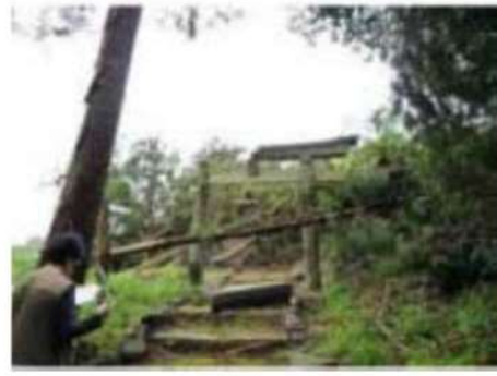
倒木の折損と鳥居の被害
