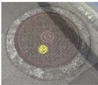
マンホール蓋
