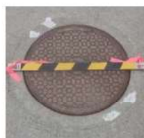
マンホール蓋
