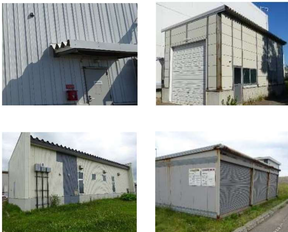
図18 泊発電所における屋外屋根の状況
