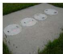
マンホール蓋
