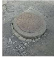
マンホール蓋
