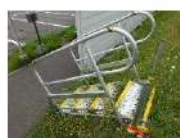
階段（単管パイプ製）
