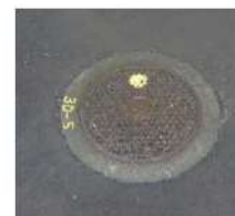
マンホール蓋
