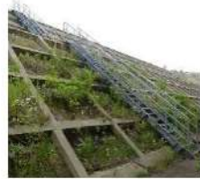
階段（H鋼製）
