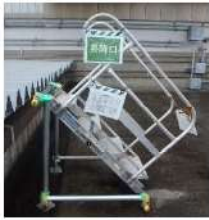
階段（単管パイプ製）
