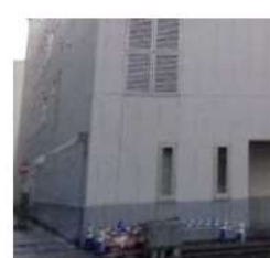
外壁 (セメント板)
