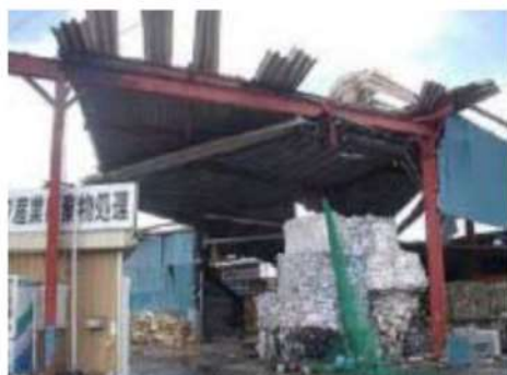
折板の損傷
