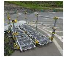
階段（単管パイプ製）
