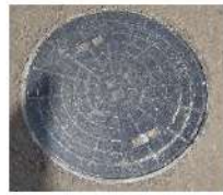
マンホール蓋
