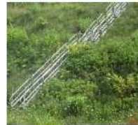
階段（単管パイプ製）
